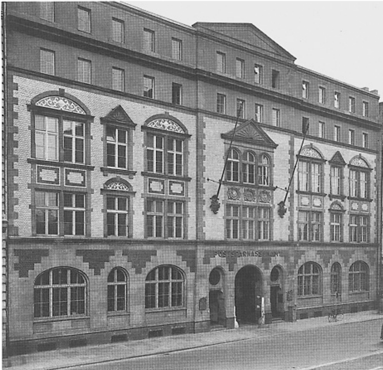
Ansicht des posteigenen Gebäudes in Hamburg, Alter Wall 55-59, in dem die Verwaltung und ein Teil des Betriebs des Postsparkassenamtes Hamburg bis 1950 untergebracht waren. Das Gebäude war vom Bombenkrieg beschädigt worden. Die beiden oberen Stockwerke wurden bei der Wiederherstellung aufgesetzt.
